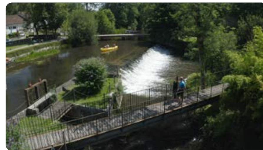
Montagrier - Plan drone - Couple passerelle
